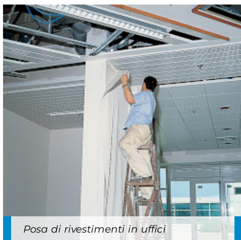
Posa di rivestimenti murali in teli con Adesilex MT32
