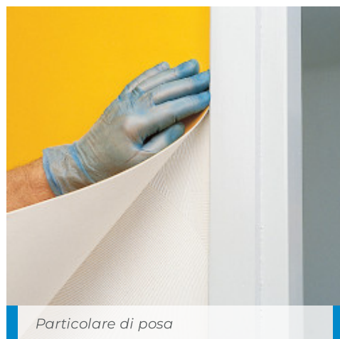
Posa di rivestimenti murali in teli con Adesilex MT32
