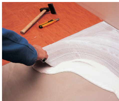
Stesura di Adesilex V4 per la posa di quadrotte di PVC omogeneo
