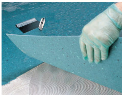
Posa di quadrotte in PVC omogeneo su Adesilex V4 con registrazione su due lati adiacenti
