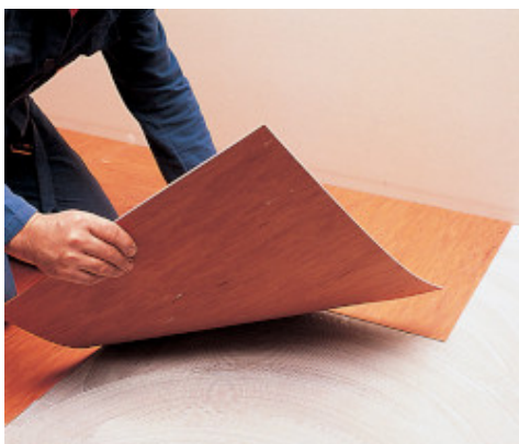
Posa su Adesilex V4 di pavimento in PVC omogeneo in quadrotte
