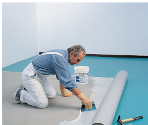
Stesura di Adesilex V4 per la posa di PVC eterogeneo in teli contigui
